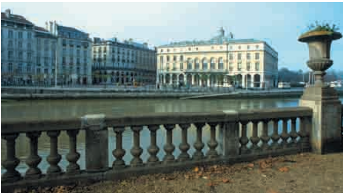
Baionako Udaletxea, Réduitetik ikusita. Palacio del Ayuntamiento de Baiona desde la Réduit
